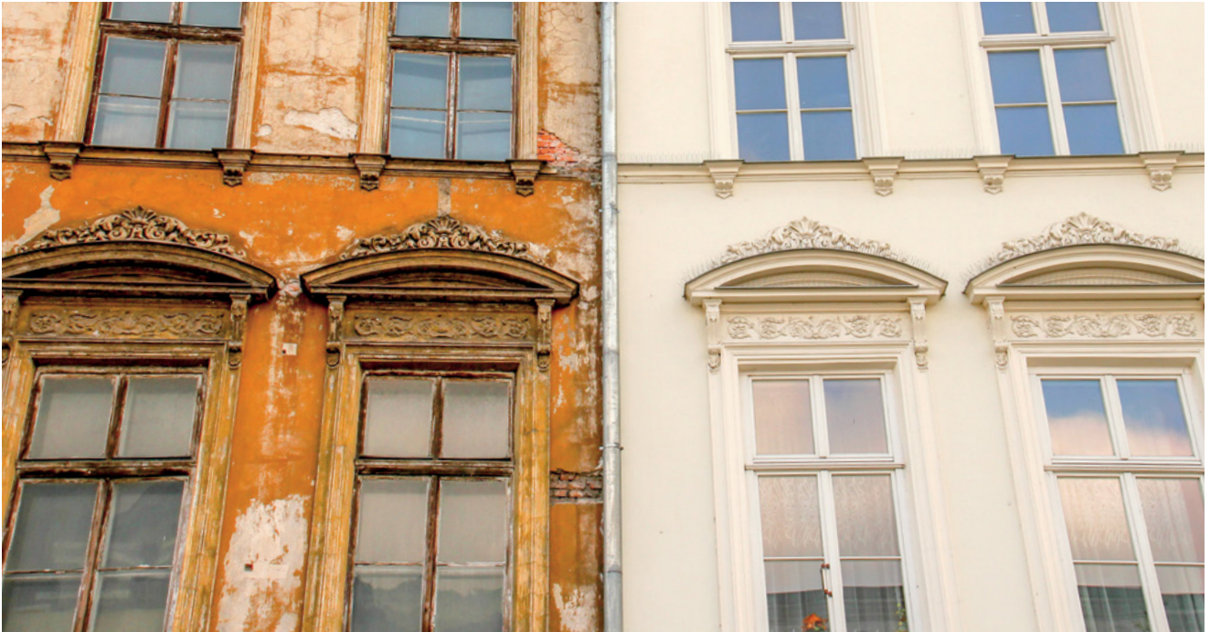
Beispielbild einer Denkmalsanierung
